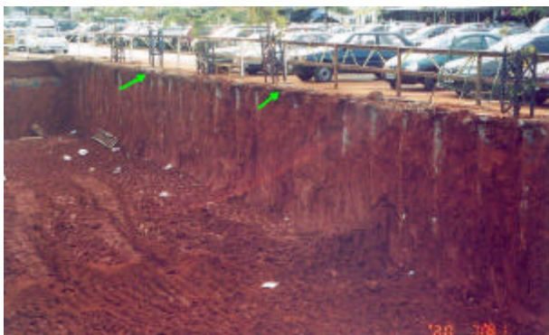
Figura 5: Vista da obra e estacas instrumentadas
