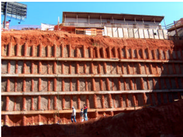
Figura 6. Vista Geral da Fachada Oeste, Obra no Setor Bancário Sul.
