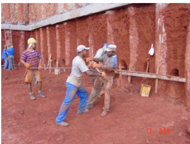
Figura 5. Detalhe da perfuração com o trado manual para instalação dos grampos, Obra 2 – Setor Bancário Sul.
